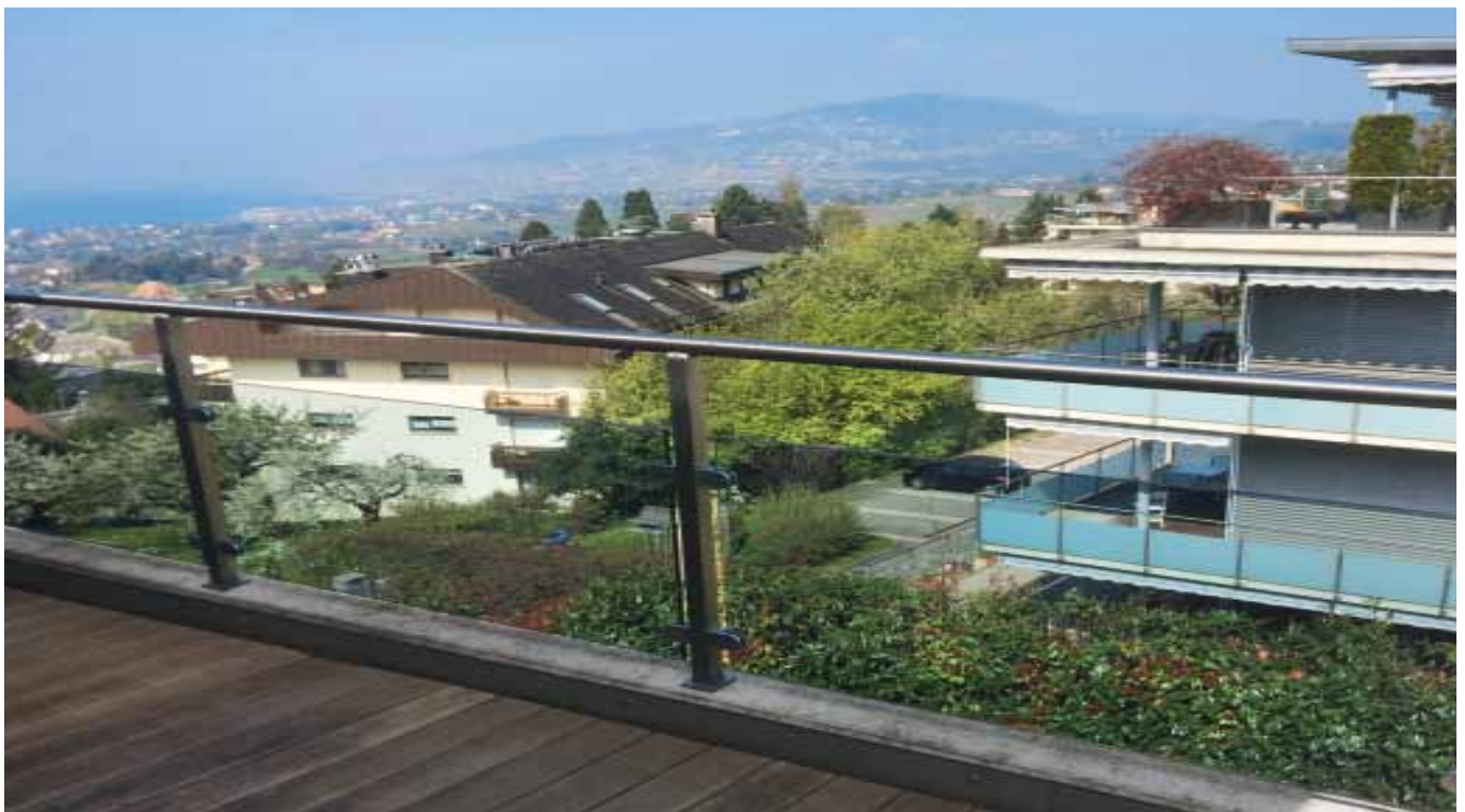
Garde-corps en verre conforme à la norme SIA 358
